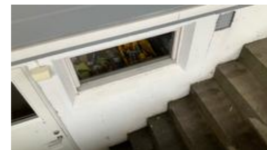
Grunnmur av betong.
