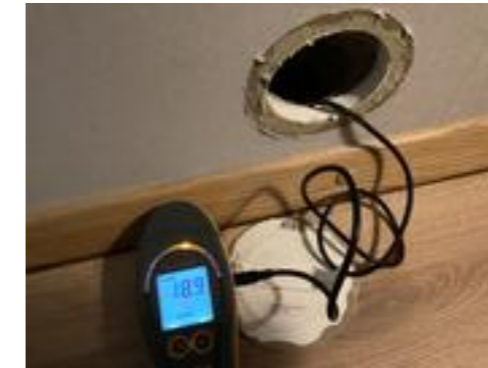
Bilde av fuktmåling via hulltaking.
