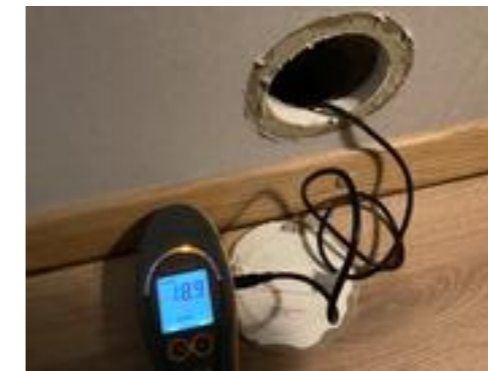
Bilde av fuktmåling via hulltaking.
