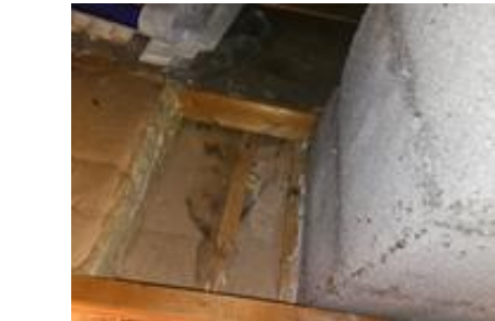
Spor etter lekkasje ved pipen
