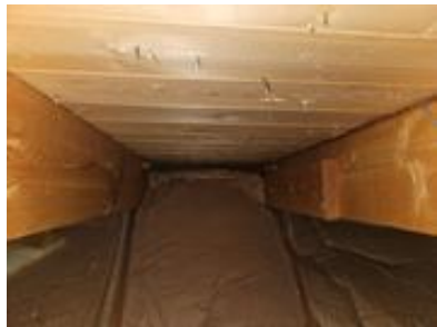
Lufting mellom undertaket og isolasjon i skrå takflater
