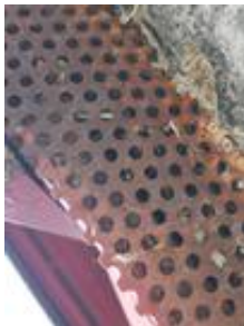
Beslagene i underkant av bordkledningen har begynnende rustdannelser
