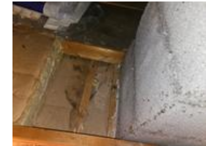
Spor etter lekkasje ved pipen
