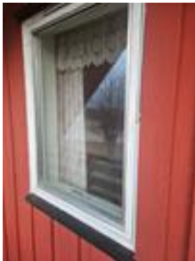
Vinduene har karmen av tre og isolerglass
