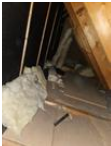
Det har vært en lekkasje ved de isolerte kanalene lengst inne i raftekottet
