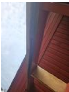
En råteskadd bjelke over verandaen foran loftet
