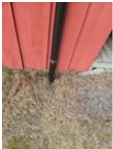
Taknedløp er ført ned i terrenget, usikkert hvor det evt ledes videre
