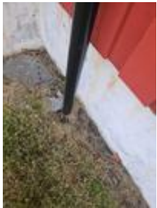
Taknedløp er avsluttet over terrenget
