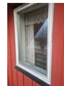
Vinduene har karmen av tre og isolerglass
