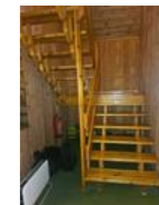
Innvendig trapp av tre mellom etasjene.
