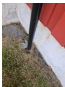
Taknedløp er avsluttet over terrenget
