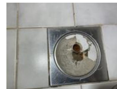
Sluk/avløp i dusjsone
