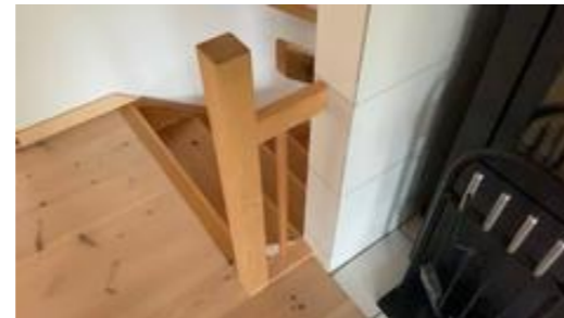
Løst rekkverk.
