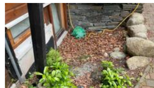
Terreng som faller inn mot mur.
