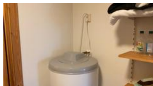
Varmtvannsbereder tilkoplest støpsel/kontakt.
