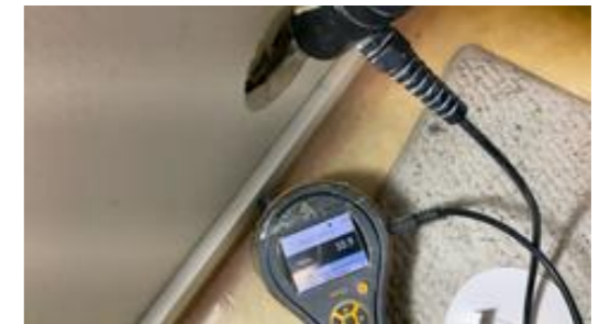
Fuktsøkt i vegg mot bad/hjørnekar uten unormale forhold.
