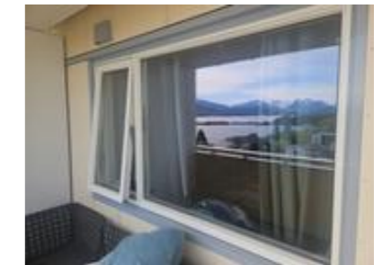
Vindu med karmen av tre og isolerglass
