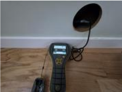
Fuktmåling mot bad i hovedetasje.
