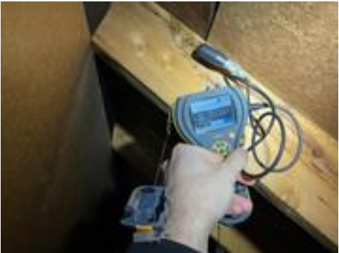
Det er ikke unormale utslag ved fuktmåling.
