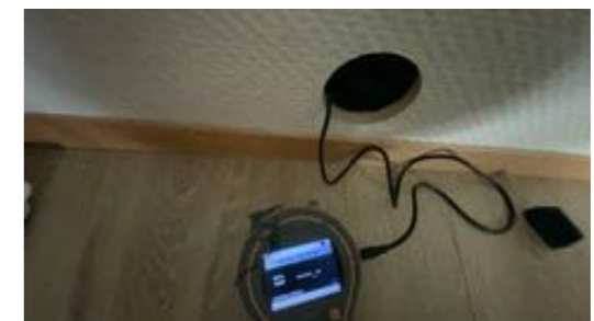
Hulltaking er foretatt i vegg fra tilstøtende soverom.
