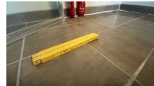
Nedsenk for dusjnisse er mindre enn 10mm som er minstekrav iht. de preaksepterte ytelser knyttet til TEK17.
