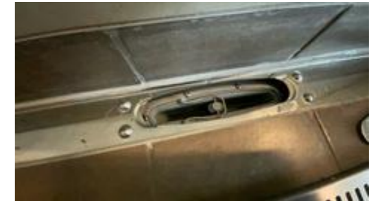
Slukrenne langs vegg i dusjnisse, uten synlig membran.
