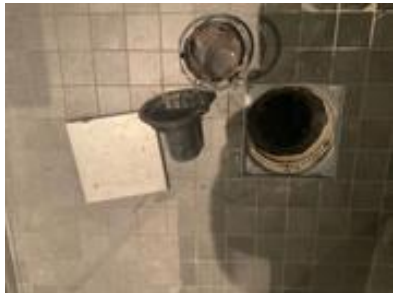
Sluket i dusjsone
