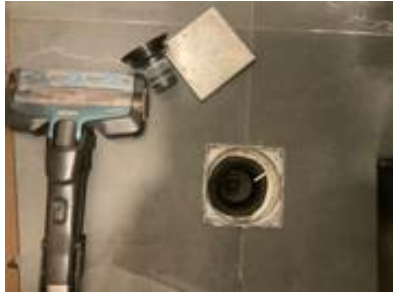
Sluket i teknisk rom
