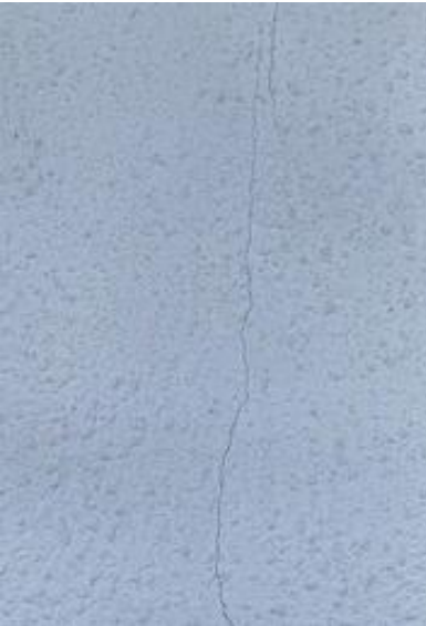
Eksempelbilde av sprekk i yttervegg mot bod i sokkel.
