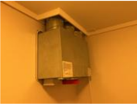
Sentralavtrekk. Aggregatet henger i boden
