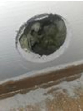
Ingen indikasjon på unormal fukt i veggen
