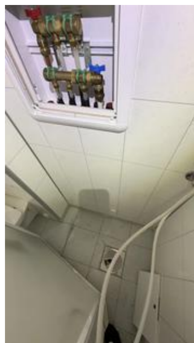
Eksempelbilde av fordelerskap i dusjsone.
