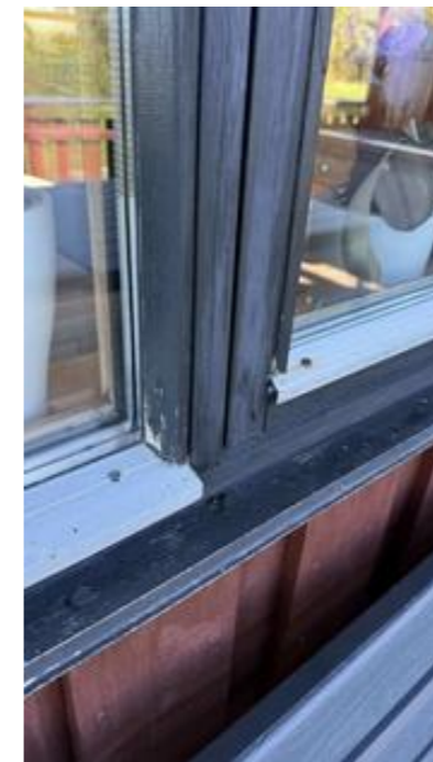
Eksempelbilde av værslitasje/ malingsavlass.
