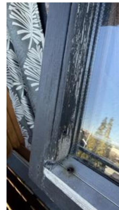
Eksempelbilde av værslitasje/ malingsavlass.
