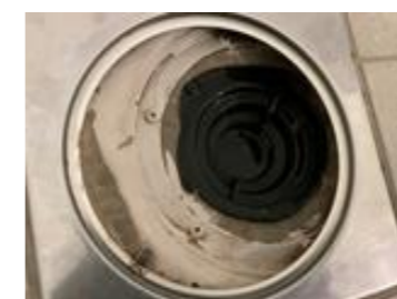
Oversiktsbilde av sluk
