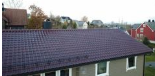
Takside sør. Snøfangere langs deler av takfoten
