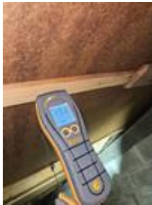
Ikke unormal fukt i underkant av bjelkelaget
