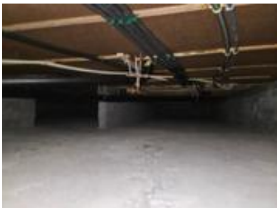
Krypkjeller under huset
