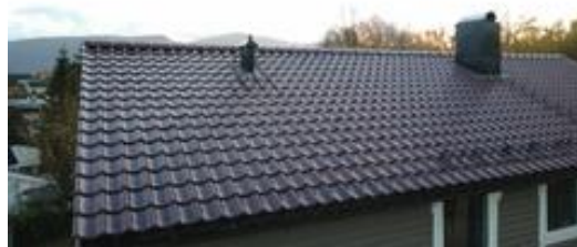
Takside nord. Snøfangere langs deler av takfoten
