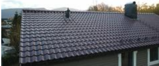
Taket er tekket med teglstein
