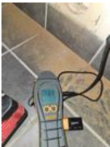
Ingen indikasjon på unormal fukt i vegg
