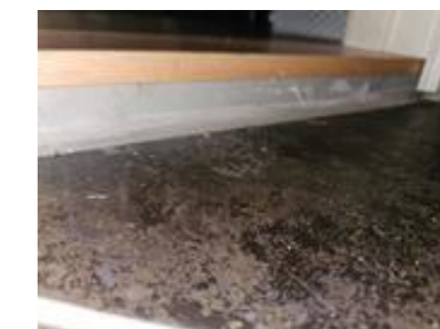
Oppkant under døren, dekket med silikonfuge
