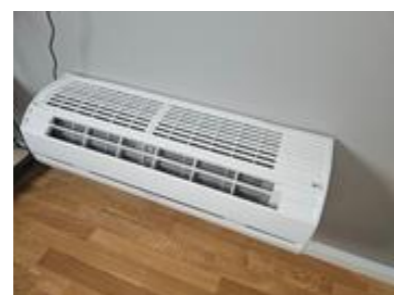
Luft til luft varmepumpe
