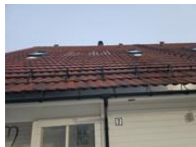
Snøfanger langs deler av takfoten
