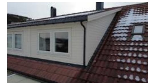
Taket er tekket med metallplater
