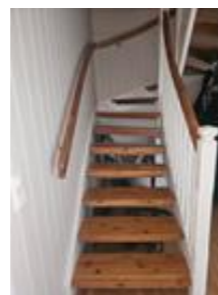
Innvendig trapp av tre mellom etasjene.
