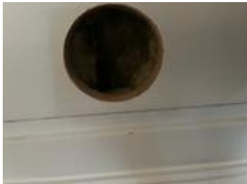
Hull for søk etter fukt i tilstøtende konstruksjoner til våtsoner.
