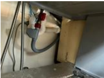
Røropplegget til kjøkkenbenken.
