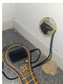
Ingen indikasjon på fukt i vegg
