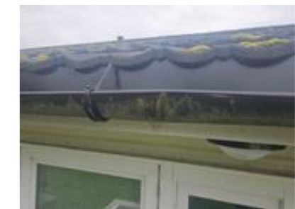
Bulk i takrenne mot vest
