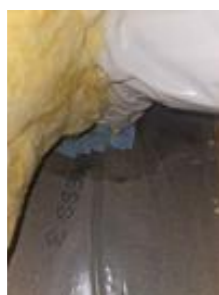
Gjennomføring for avtrekkskanal fra oversiden
