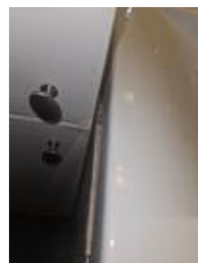
Forskjøvet og fuktskadede skapsider, servantskap.
