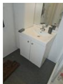
Forskjøvet og fuktskadede skapsider, servantskap.
