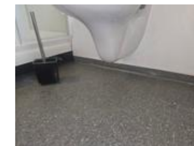
Vegghengt wc uten dreneringsåpning i kasse
