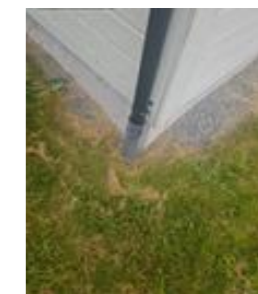
Takvannet ledes til rør i grunnen
