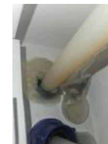
Uttetthet inne i fordelingskapet
