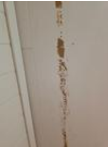
Taket buler og det er skrudd fast med synlige skruer. Det er også påvist fuktsmerker flere plasser i taket i leiligheten
