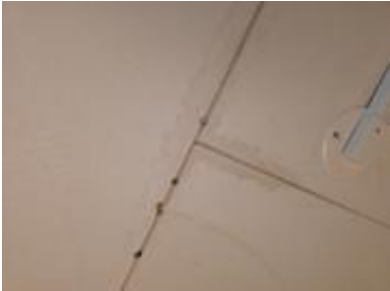
Taket buler og det er skrudd fast med synlige skruer. Det er også påvist fuktsmerker flere plasser i taket i leiligheten
