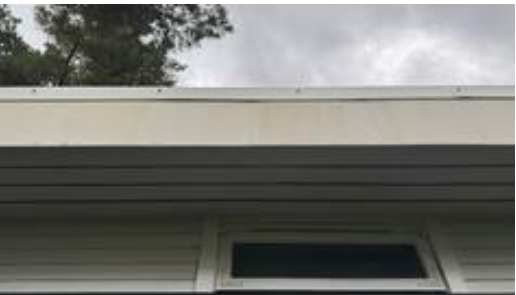
Ytre plater er av eternitt. Vanlig bygningsmateriale i 1965.
