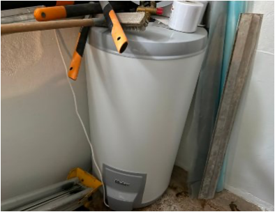
Varmtvannsbereeder (200 liter).
