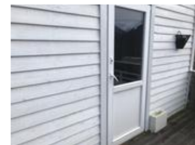
Nyere pvc balkongdør
