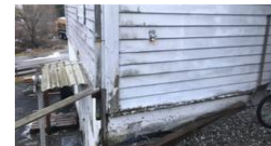
Bordkledning på sørfasade ble skiftet for ca. 8 år siden.
