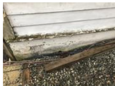
Synlig grunnmursplast rundt deler av huset.
