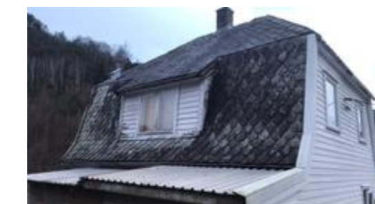
Takplater over inngangsparti.
