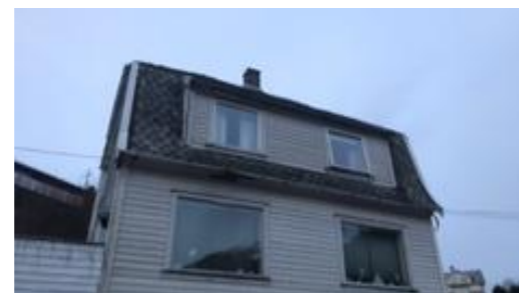
Det er observert løse/manglende skiferstein.
