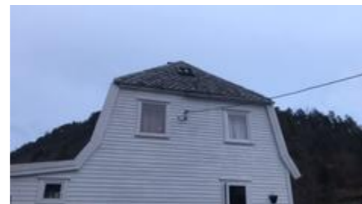
Det er observert løse/manglende skiferstein.
