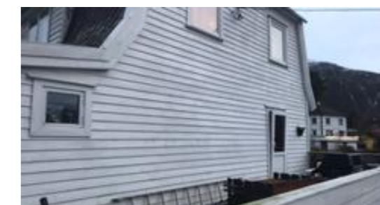
Bordkledning på sørfasade ble skiftet for ca. 8 år siden.
