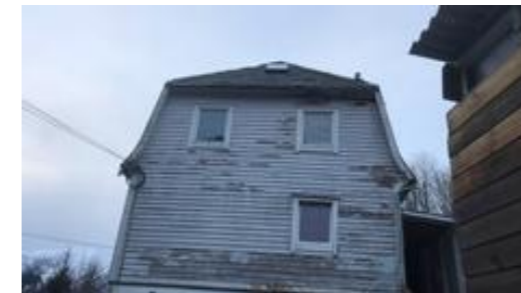
Mosegroe på taktekking.
