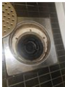
Plastluk med mansjett og klemring
