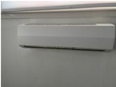
Viser varmepumpe.
