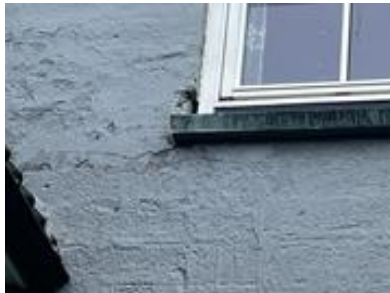
Viser sprekker/avskallinger.
