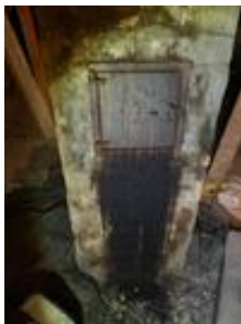
Viser for liten brannsikker plate foran peisovn.
