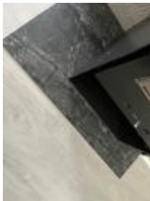
Viser for liten brannsikker plate foran peisovn.
