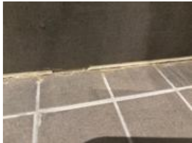
Viser at silicon løsner
