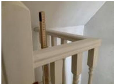
Lavt rekkverk, her på gulv
