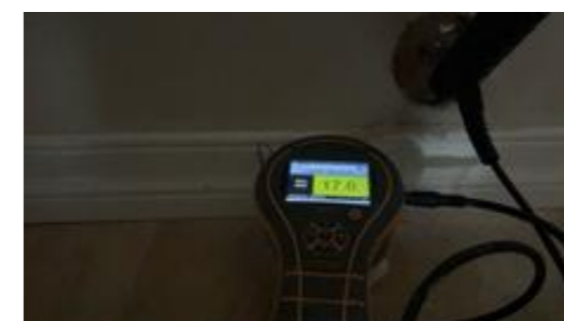
Fuktmåling i gul sone
