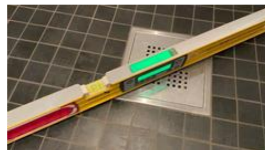
Godt fall i dusjsone.
