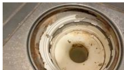
Sluk med synlig duk under klemring.
