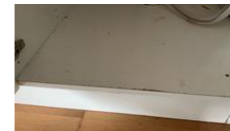
Slitasje på skap under vask
