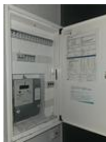
Sikringskap med automatsikringer og kursfortegnelse
