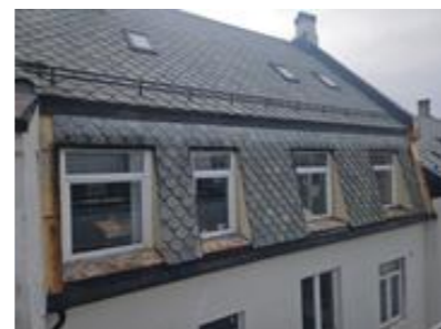
Vinduer i fasade nord
