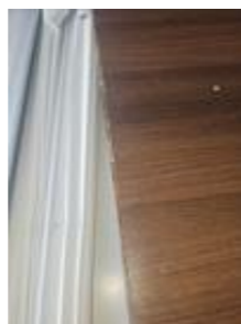
Løs kantlist på enden av benken
