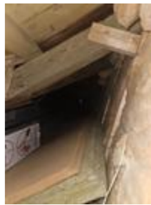
Raftekott med isolerte kneegger
