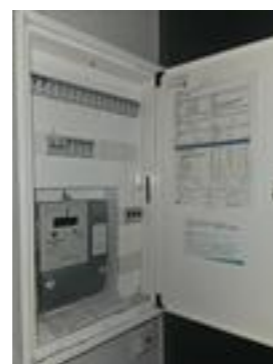
Sikringskap med automatsikringer og kursfortegnelse
