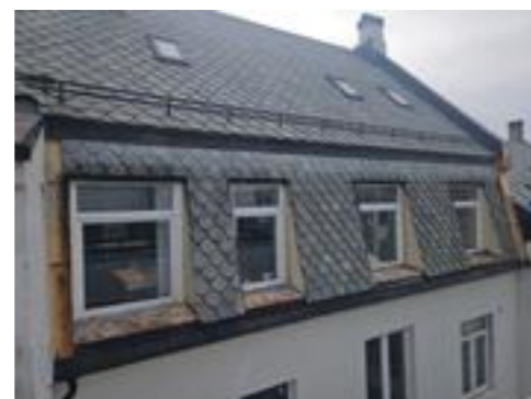
Vinduer i fasade nord
