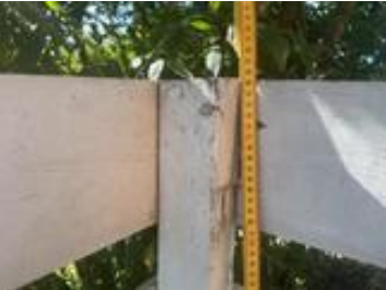
Rekkverk målt til 75 cm.
