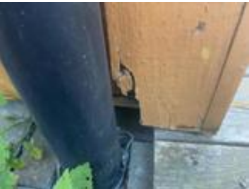
Råteskadet hjørnebord.
