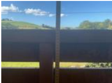
Rekkverk målt til 85 cm.
