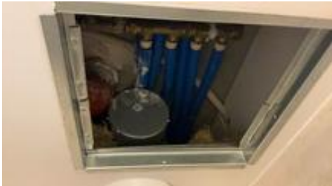
Rør i rør i innvendig tak i våtrom.
