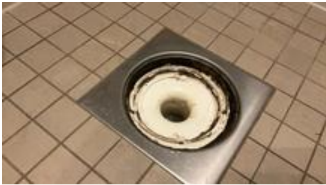
Synlig membran under klemring.
