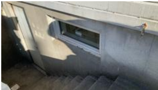
Grunnmur av betong.
