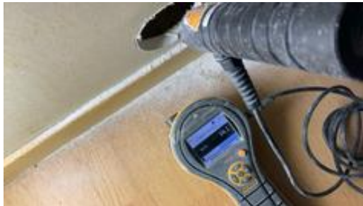
Fuktsøkt i påforet yttervegg uten unormale forhold.
