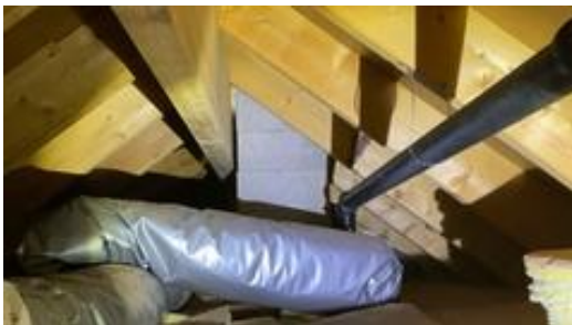
Pipe sett i takgjennomføringen.
