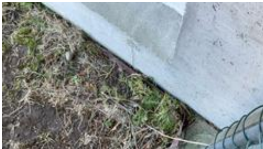
Synlig platonplast, ikke brukt list på toppen
