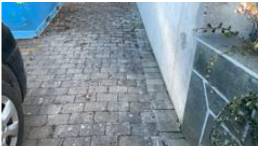
Terreng med fall mot mur.
