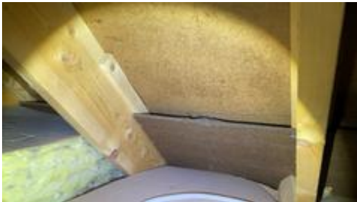
Lufting av skråtakskonstruksjon med vindtettplater.
