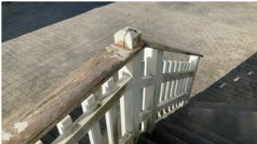
Rekkverk under behandling.
