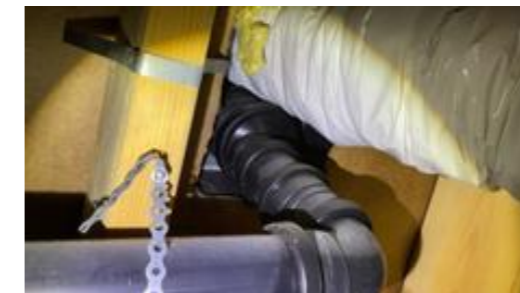
Lufting over tak sett på kaldtloft
