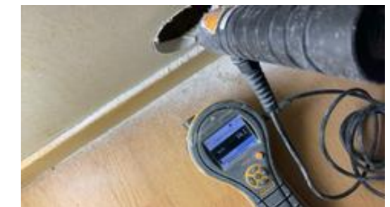
Fuktsøkt i påforet yttervegg uten unormale forhold.
