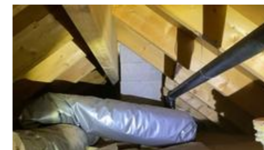
Pipe sett i takgjennomføringen.
