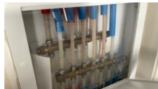
Vannfordelerskapet.
