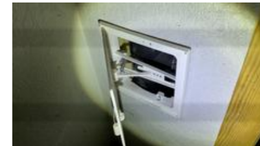
Luke med stakemulighet på avløpsanlegget.
