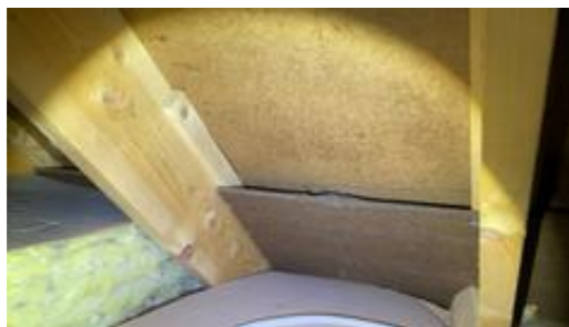
Lufting av skråtakskonstruksjon med vindtettplater.
