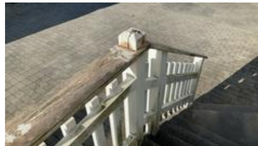
Rekkverk under behandling.
