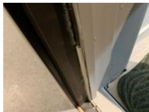
Slitte pakninger. Delvis byttet.
