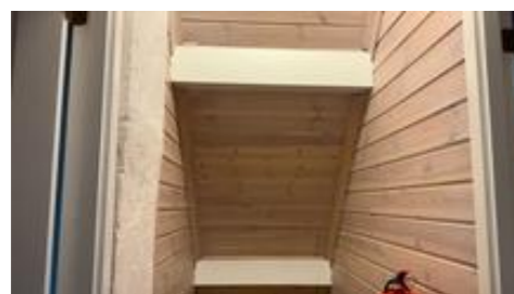
Bærende åser i takkonstruksjon.
