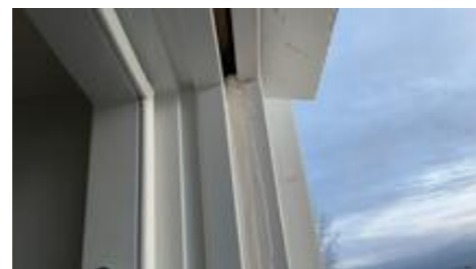
Fugemasse mellom list og karm
