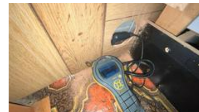
Fuktmåling med piggelektrode gav ikke utslag for fukt.
