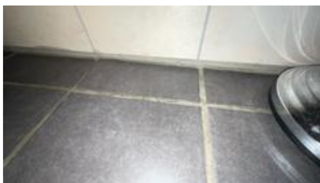
Baderomsplaten er montert helt ned mot gulv.
