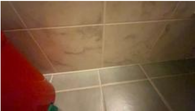
Baderomsplaten er montert helt ned mot gulv.
