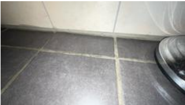
Baderomsplaten er montert helt ned mot gulv.
