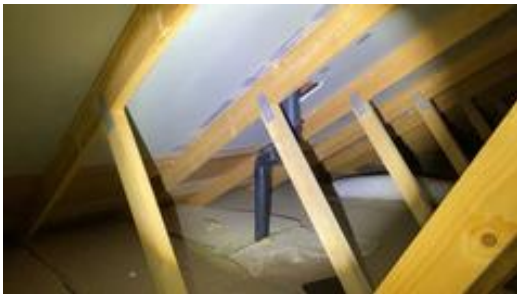
Utlufting av avløpsanlegget over tak.
