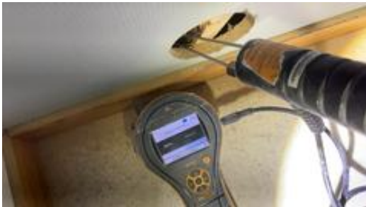
Fuktsøkt i vegg uten unormale forhold.
