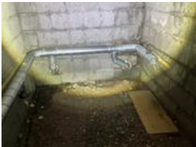
Saltgjennomslag/fukt i vegger i kryp kjeller mot nord.
