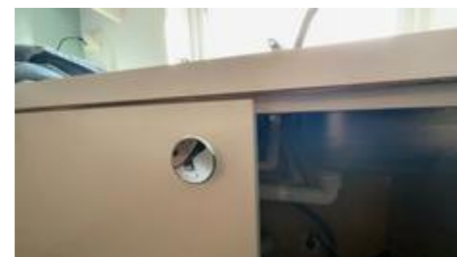
Benkeplaten sveller litt.
