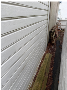
Kledningsbord bør ha minst 300 mm avstand til terreng for å unngå skader og misfarging fra vannsprut opp fra terrengoverflaten.
