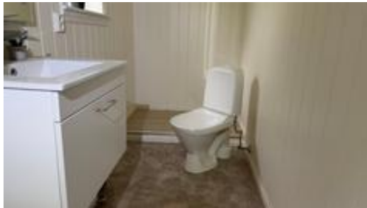
Oversiktsbilde av toalettrom.
