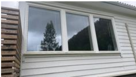
Bilde viser eksempel på nye vinduer i boligen.
