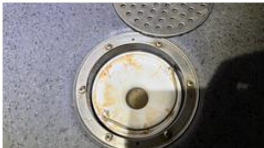
Bilde viser sluk i dusjsone.
