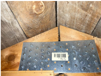
Ettermontert spikerplate
