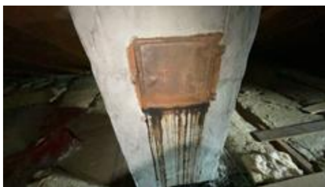
Rennemerker fra feieluken.
