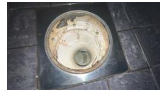
Sluk i dusjsonen. Denne ligger på en avsats høyere enn hoveddelen av gulvet
