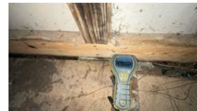
Stikkmåling etter fukt i bunnsvill.
