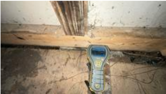
Stikkmåling etter fukt i bunnsvill.
