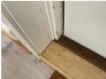
Utetthet mellom dørblad og terskel/karm-Hybel
