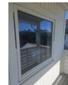
Vinduene har karmen av tre og to lag isolerglass
