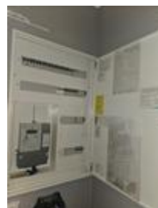
Sikringskap med automatsikringer og kursfortegnelse
